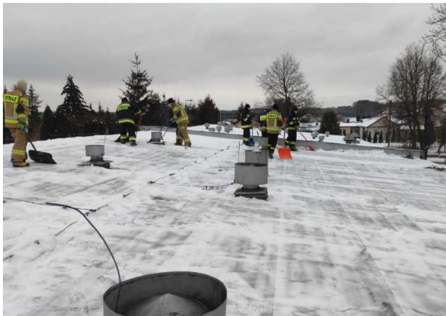
Fot. Usuwanie śniegu z dachu budynku.
