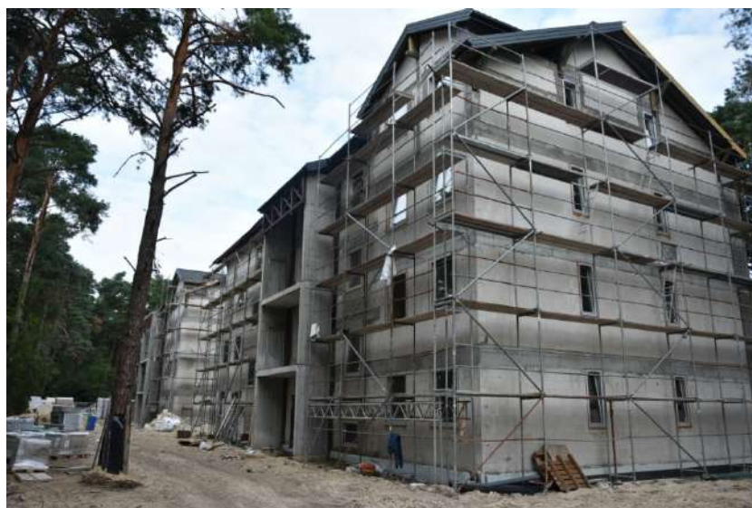
Fot. Realizacja budynków wielomieszkaniowych TBS przy ul. Poniatowskiego.
