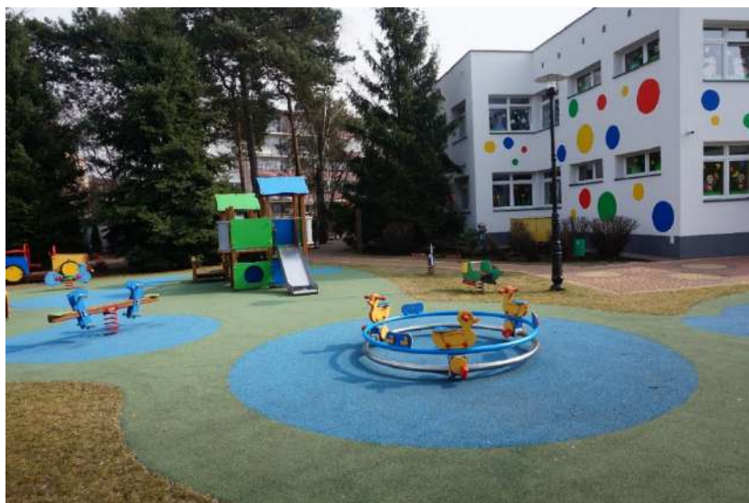
Fot. - Marzec 2022 –budynek po termomodernizacji, nowe oświetlenie zewnętrzne.
