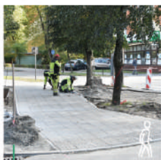
ul. Poniatowskiego przebudowa przejść na wys. ul. Kruczej i Andriollego
