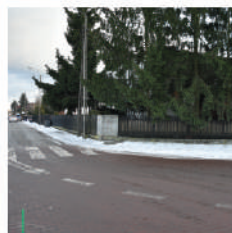
Wyniesione skrzyżowanie ul. Szkolnej i ul. Świderskiej
