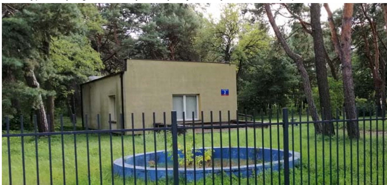
Fot. 3 Budynek administracyjno-techniczny, widok od strony ul. Batorego – wrzesień 2021 r.
