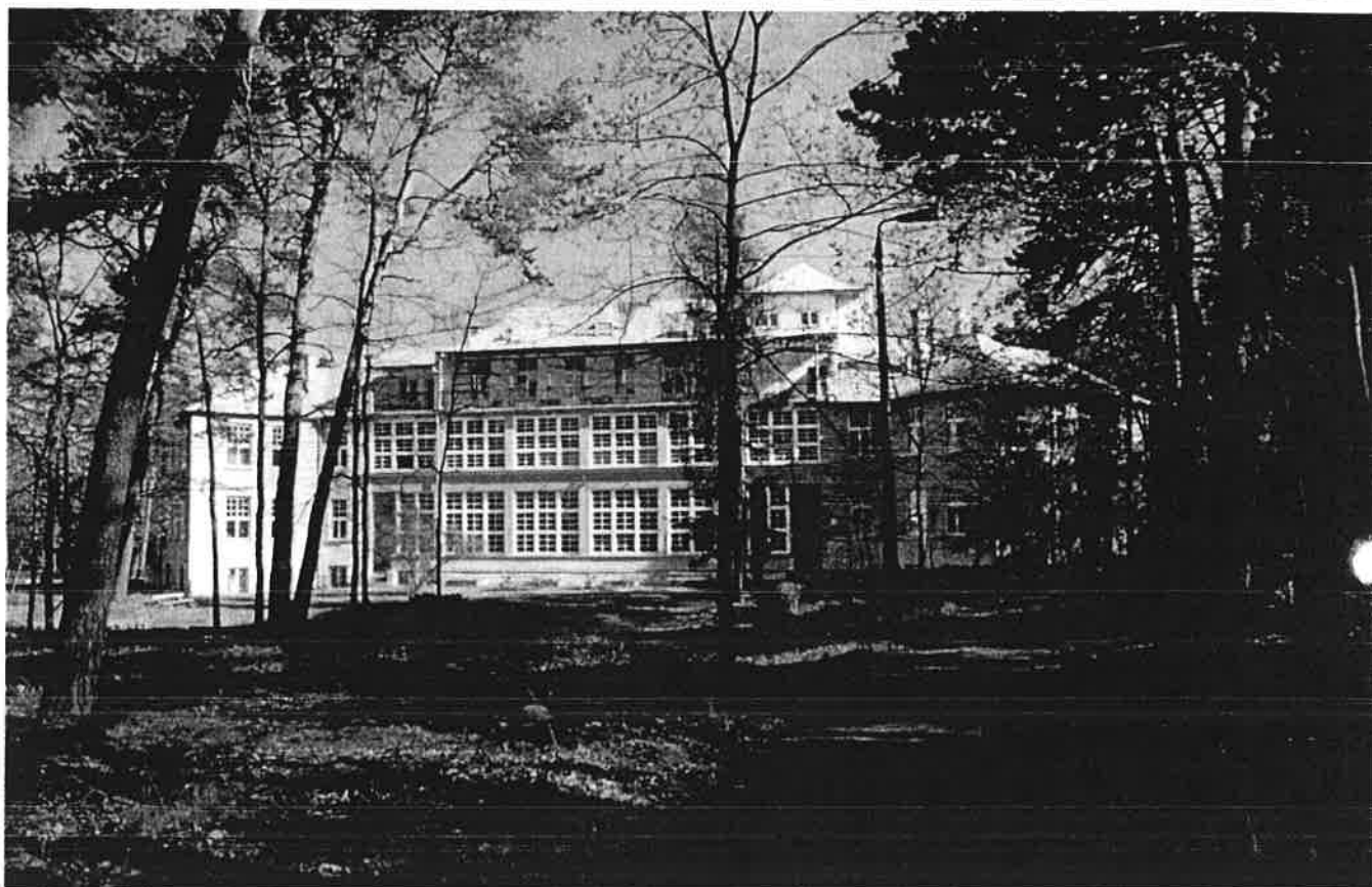
Fotografia: Budynek Mazowieckiego Centrum Leczenia Chorób Płuc i Gruźlicy
